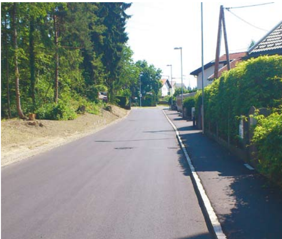
Neu asphaltiert und mit einem Gehsteig versehen wurde der Bereich Sportplatzweg/Haspingerweg.
